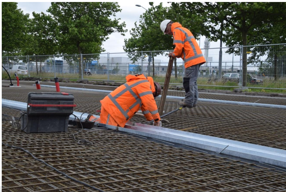
Foto: Aanleg wapening voorziening.
