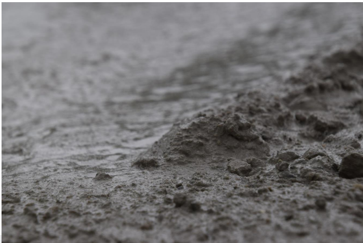
Foto: Detail betonmortel.
